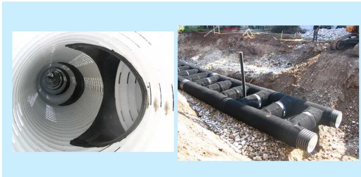
*Tubi corrugati in polietilene fessurati per il contenimento dei volumi d'acqua*
